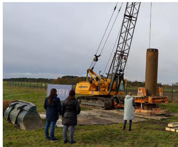
Flugplatz Manching, Bau Sanierungsbrunnen
