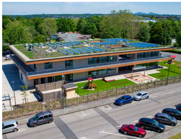
Abbildung 15: Photovoltaik auf dem Dach eines Bundeswehrgebäudes, Quelle: Bundeswehr/ Marcus Rott
