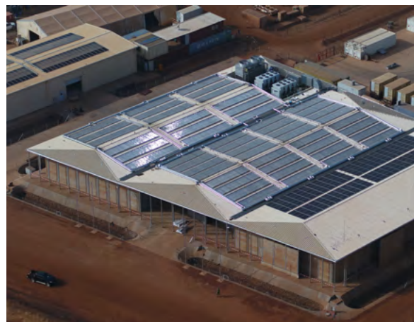
Abbildung 16: Photovoltaikanlage im Feldlager Gao/Mali, Quelle: Bundeswehr/ Marc Vigansky
